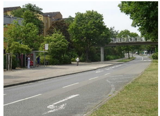
Dresdener Ring – Haltestelle „Westhagen Dessauer Straße“, Südseite
